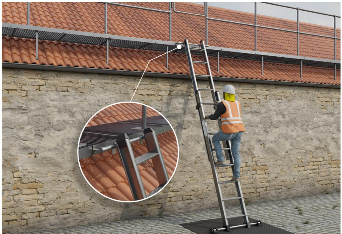
**Abb. 19** Leiter mit fester Einhängenvorrichtung an einem ertüchtigten Bestandsgebäude mit gesichertem Überstieg
