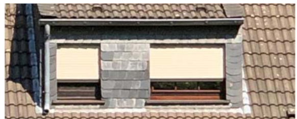
Anschlüsse aus Blei rund um die Gaube
