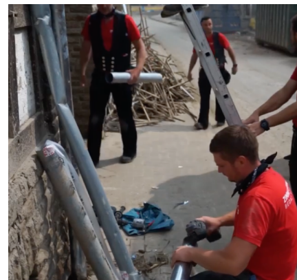
Mitarbeiter der Firma Zimmermann Bedachungen bringen Fallrohre an. Quelle: TV Mittelrhein
